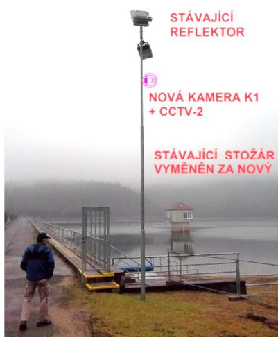
Obr. 6-1 Nová kamera K1 na novém stožáru u vjezdu na hráz
