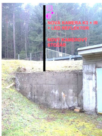
Obr. 6-3 Nová kamera K3 na novém stožáru u pravobřežního vstupu do hráze
