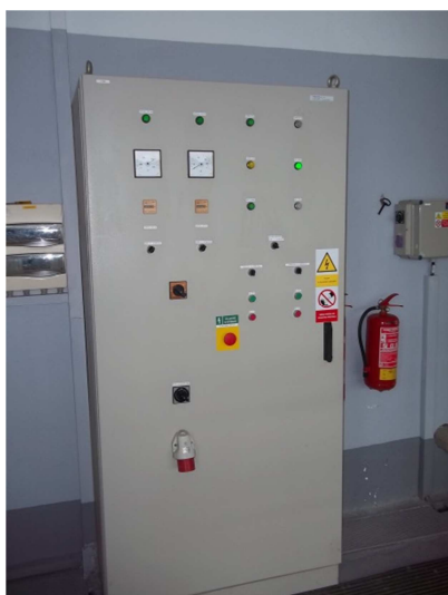
Obr. 6-4 Stávající rozvaděč NN v odběrné věži
