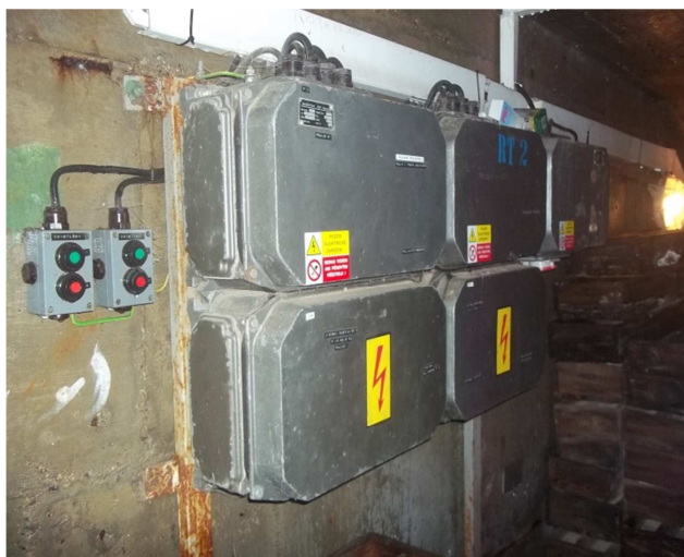
Obr. 6-3 Stávající NN rozvaděče v pravobřežním vstupu do hráze
